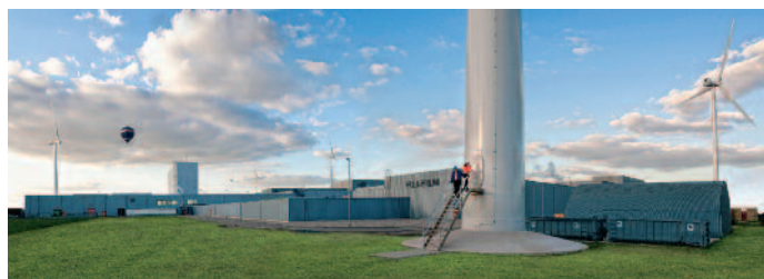
Das Werk ist auf besondere Nachhaltigkeit ausgerichtet. 20% des gesamten Energiebedarfs werden mit fünf Windkraftanlagen abgedeckt.
